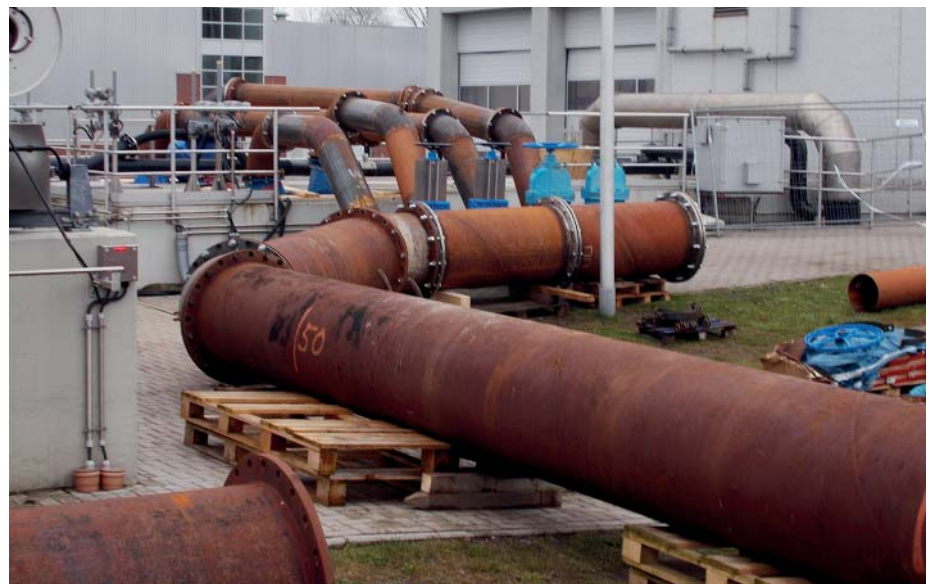
Bei der Sanierung des Hochwasserpumpwerks der Kläranlage lieferte und installierte die Xylem-Mietstation Bremen das komplette Pumpenprovisorium. (Foto: Xylem)
